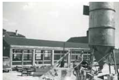
Bau des neuen Firmengebäudes in Thalheim (Bruckhofstraße)
